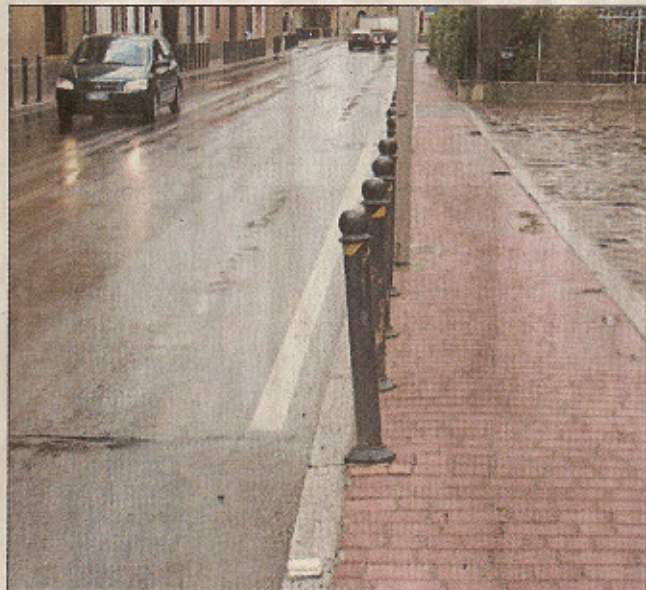
■ Il tratto riqualificato recentemente della ex Strada Statale 42
